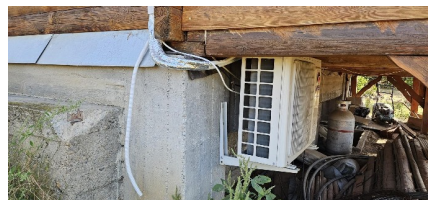
13.1 Klíma kültéri egységének elhelyezése
