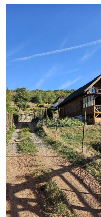
06.2 Telekhatár a mellékút mellett
