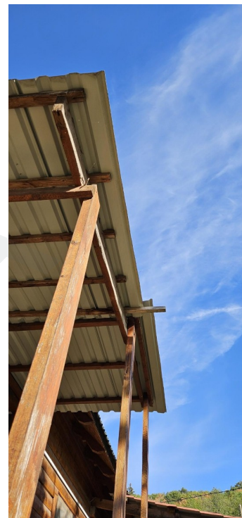
23.1 Fedett terasz tetőcsatlakozása
